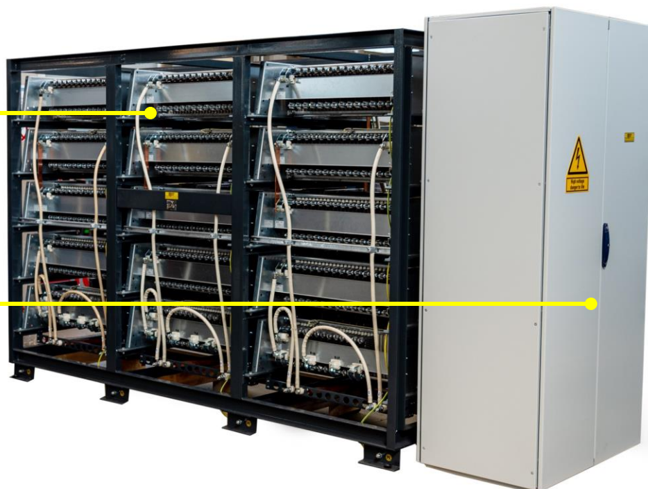
Пусковой реостат с воздушным охлаждением для конвейера
